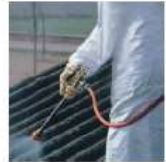
1) Stecura del fissante Ecofix certificato secondo norma UNI 10686
