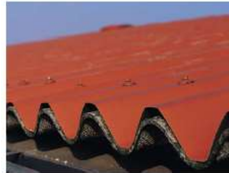
3) Incapsulamento dell'esistente fibrocemento + ETERAL SYSTEM!!!
